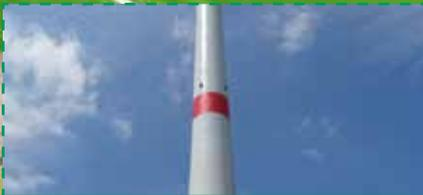
Im Turm befindet sich ein Aufzug und eine Leiter. Der Hybridturm besteht aus 83 m Beton und 56 m Stahl.
