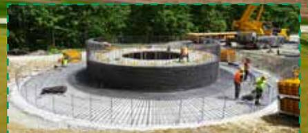
Stahlbewehrtes Ringfundament mit einem Durchmesser von 20 m und einer Höhe von 1,30 m außen sowie 3,87 m innen.
