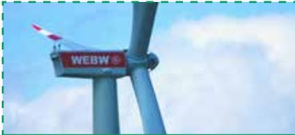
Die Nabhöhe der Anlagen liegt bei 139 m. Der Rotordurchmesser beträgt 120 m.
